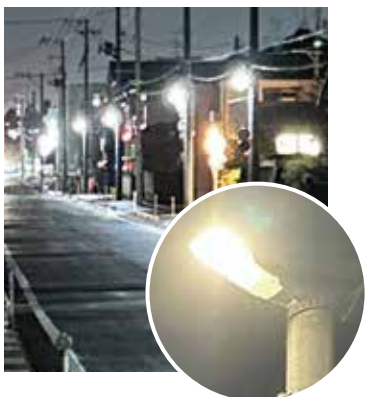
蛍光灯からLED灯へ全て交換済
