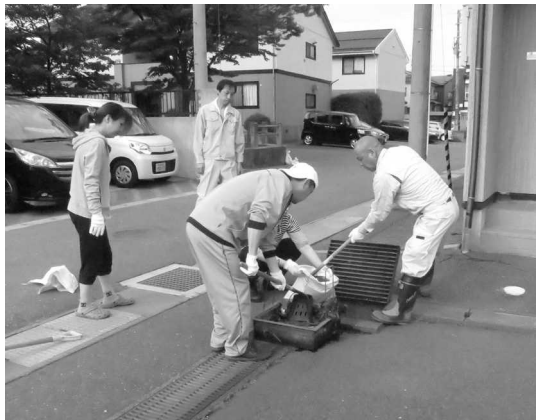
一斉下水溝清掃
