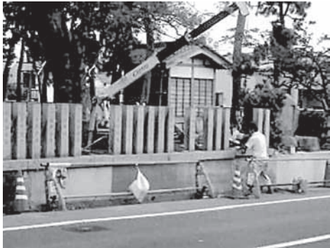
( 玉垣設置工事 )
