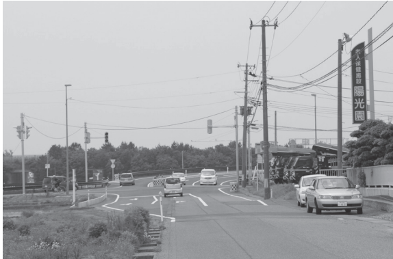
工事が進む姥ヶ山 IC
